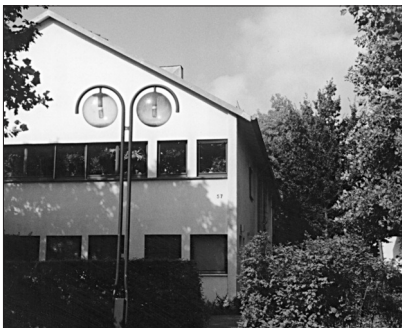
Turnhalle Bahnhofstraße (vormals Kino) – Übergabe 1979
